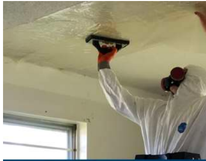
Test Site 2 (TS2) - Asbestos Ceiling
